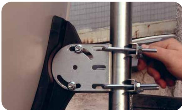
Zloženú parabolu pripevnite na anténovú konzolu. Nastavte približný smer (azimut a elevačný uhol) a mierne pritiahnite skrutky tak, aby sa parabola dala jemne doladiť.
